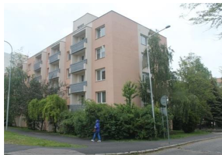
budovy zariadenia – pavilón A a pavilón B
